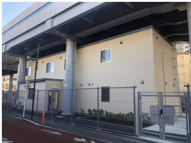
竣工した建物
