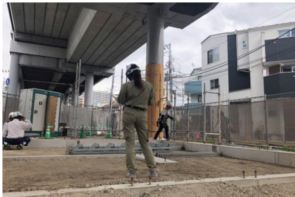
現場作業風景
